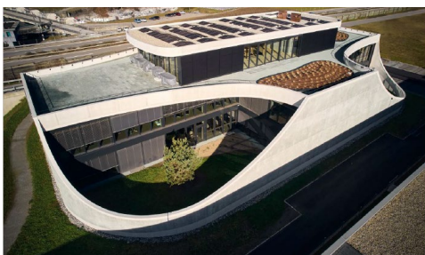
La nuova sede principale dello studio di ingegneria e progettazione Grünenfelder e Partner si distingue per le forme arrotondate, che insieme ai solai realizzati come solette a sbalzo hanno richiesto una struttura adeguata per il tetto.
