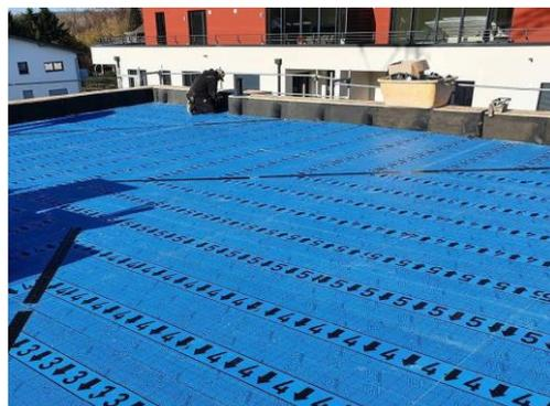
*Une toiture isolée à forme de pente réalisée avec EFYOS Blue Smart présente une esthétique nette et précise, avec une identification claire de l'orientation des pentes.*
