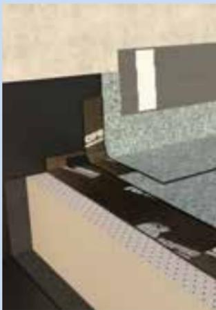
Ersetzt man den Deckstreifen bei geeignetem Untergrund durch Flüssigkunststoff, entsteht bei entsprechender Untergrundvorbereitung ein höchst hinterlaufsicherer, wartungsarmer und preiswerter Abschluss, der eine extreme Zugkraft aufnehmen kann und die Bitumenbahnen vor dem Abrutschen auch bei hohen Temperaturen sichert.
