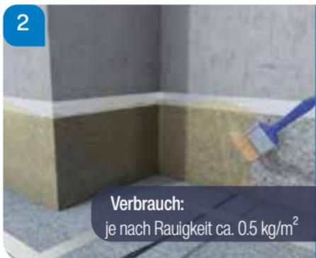
Fläche im Bedarfsfall gemäss Untergrundtabelle grundieren. Beschieferte Bahnen müssen nicht grundiert werden. Grundierung Alsan PMMA 171 mittels Roller oder Pinsel filmbildend auftragen.
