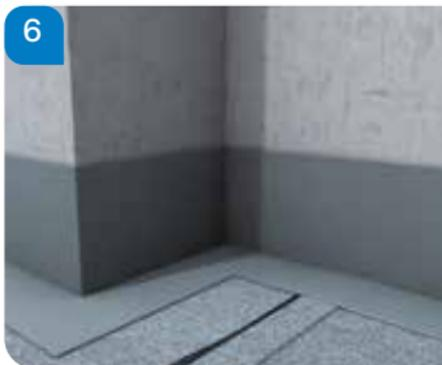
Das Abdeckband sofort im noch nassen Zustand des Abdichtungsharzes entfernen. Bei zu spätem Entfernen und bereits erfolgter Reaktion des Materials, kann es zu Ablösungen im Randbereich kommen. Falls das Material bereits hart ist, muss das Kleband unter Umständen mittels Cutter entfernt werden, was die frische Abdichtung beschädigen kann.
