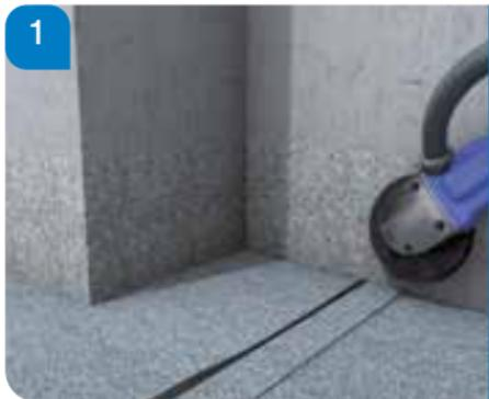
Vor Beginn der Abdichtungsarbeiten mineralische Anschlussbereiche anschleifen. Lose Schieferschuppen der Bitumenbahn mittels Drahtbürste entfernen. Mit PE-beschichtetem Abdeckband abkleben. Abdeckband auch zur Entkopplung von Fugen oder Materialübergängen verwenden. Fläche danach gründlich mit einem Staubsauger reinigen.
