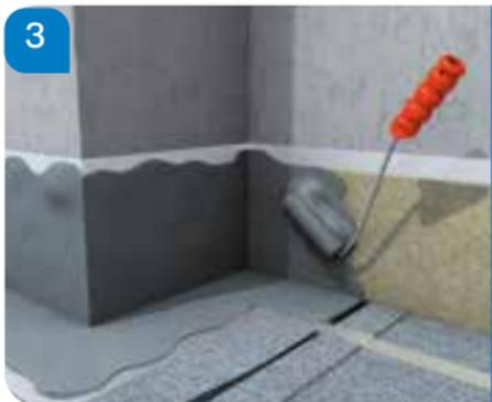
Nach Aushärtung der Grundierung, Einbettschicht vorlegen. Vor allem bei Materialübergängen, im Eckbereich oder bei vertikalen Flächen ausreichend das Abdichtungsharz Alsan PMMA 770 TX vorlegen (ca.  $1.5 \text{ kg/m}^2$ ).
