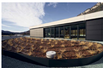
Les nombreux relevés, ici sur les bacs de végétalisation, ont exigé un travail méticuleux de l'entreprise de couverture.
