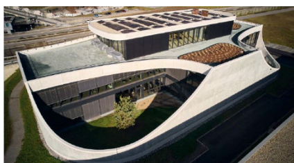
Le nouveau siège de la firme Grünenfelder und Partner privilégie les formes arrondies. Cette architecture avec ses surplombs et auvents avait besoin d'une structure de toiture appropriée.
