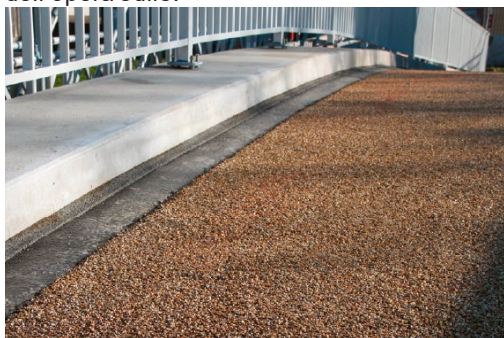
Figura 4: Il sigillante con resina sintetica per impermeabilizzazioni sotto asfalto colato garantisce il buon esito dell'opera edile.
