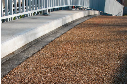
Bild 4: Eine Kunstharzversiegelung für Abdichtungen unter Gussasphalt ist ein Garant für ein gelungenes Bauwerk.
