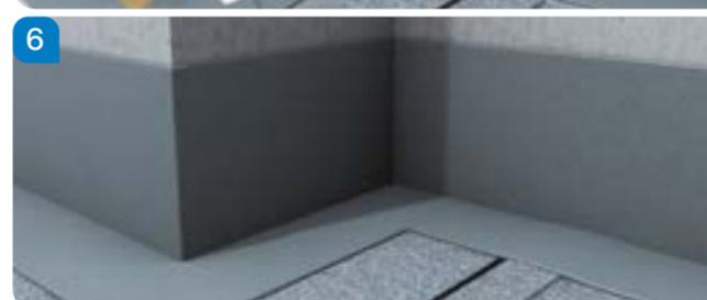
Dopo l'applicazione rimuovere immediatamente il nastro di copertura.
