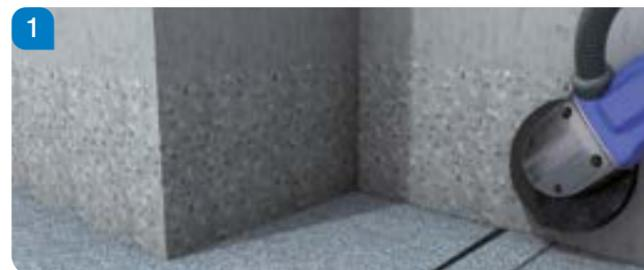
Pretrattare l'area del raccordo in materiale minerale mediante bocciardatura o levigatura.
