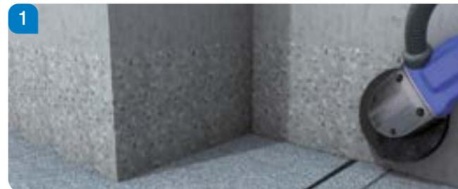
Préparer par ponçage ou bouchardage les zones de raccord du support minéral.
