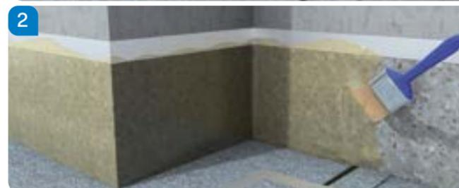
Si nécessaire (voir tableau des supports), appliquer un primaire sur la surface préalablement délimitée avec une bande de masquage.
