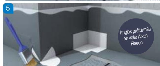
Recouvrir le voile d'une couche de finition.
