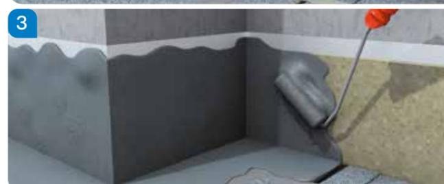
Nach Aushärtung der Grundierung, Einbettschicht vorlegen.
