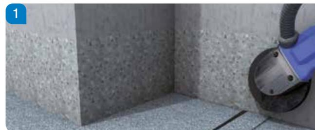
Mineralische Anschlussbereiche vorbereiten durch Stocken oder schleifen abschleifen.
