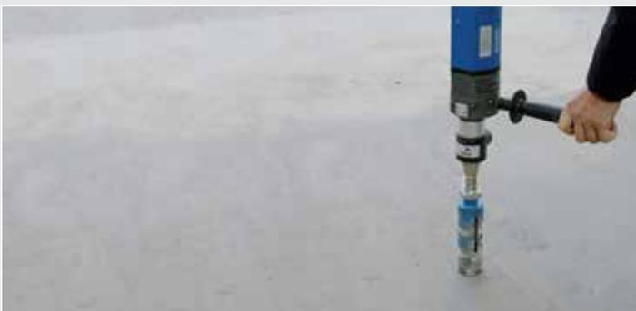
4. **Se non si conosce la strutturazione degli strati del sottofondo** o se ad esempio possono essere presenti cavità o umidità nel sottofondo, in determinati punti bisogna **effettuare perforazioni** di prova e analisi.
