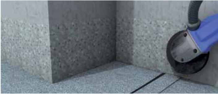
**1.** Prima dell'inizio dei lavori di impermeabilizzazione bisogna levigare le aree del raccordo. Rimuovere le scaglie di ardesia staccatesi dalla membrana bituminosa tramite spazzole con setole in acciaio. Incollare un nastro di copertura rivestito con PE. Utilizzare il nastro di copertura anche per separare le giunzioni o passaggi difficili dei materiali.
