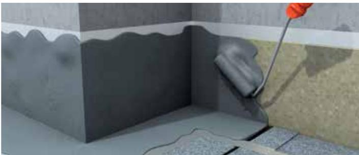
**3.** Dopo un tempo di attesa di ca. 20 min applicare uno strato di inserimento. Assicurarsi di applicare materiale a sufficienza (ca. 1,5 kg/m<sup>2</sup>) soprattutto nei passaggi da un materiale all'altro, nelle aree ad angolo o su superfici verticali.
