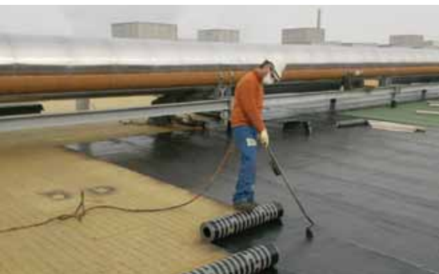
Pose de la 1ère couche de lé d'étanchéité en bitume élastomère
