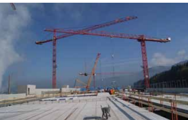
Surface de la toiture
