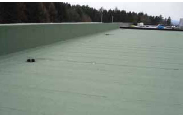
Le relevé d'étanchéité de la toiture nue avec une finition ardoisée
